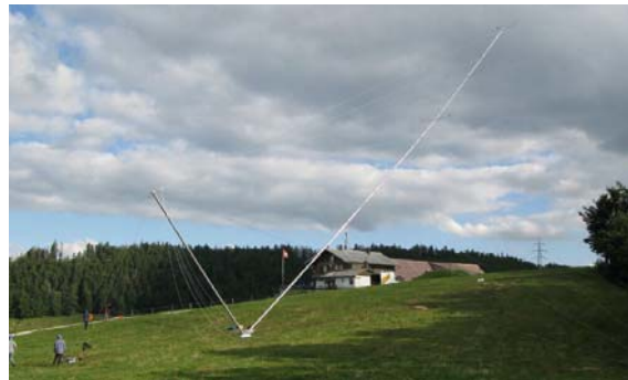
Aufrichten des Windmessmastes
