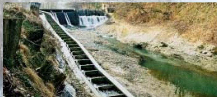
Fischtreppe und Restwasserstrecke
