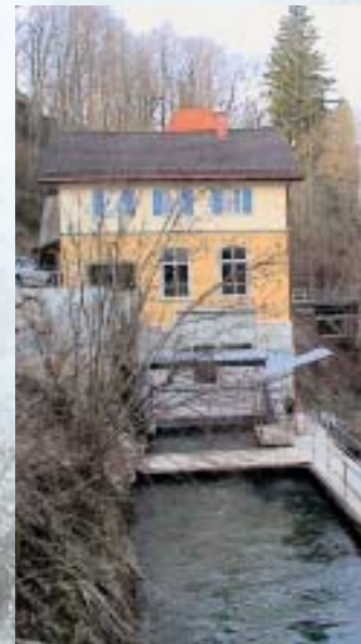
Maschinenhaus mit Rechenreinigungsanlage
