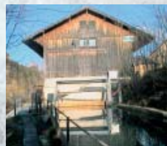
Oberwasserkanal und Rechenreinigungsanlage
